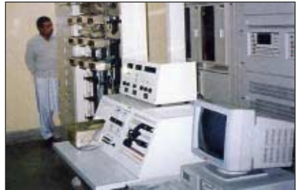
サイト写真：ムルタン交換局
