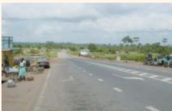
本事業により改良された道路
