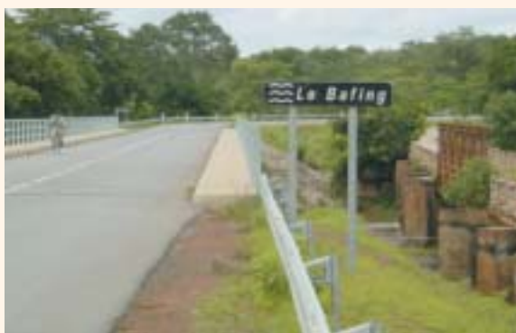
本事業により整備された道路
