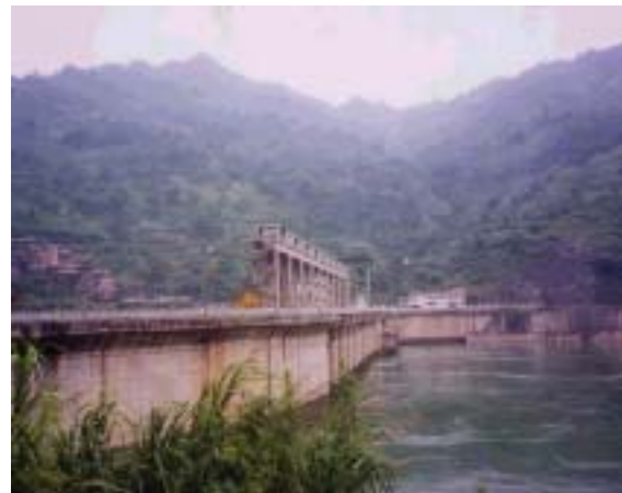
サイト写真：天生橋第二発電ダム
