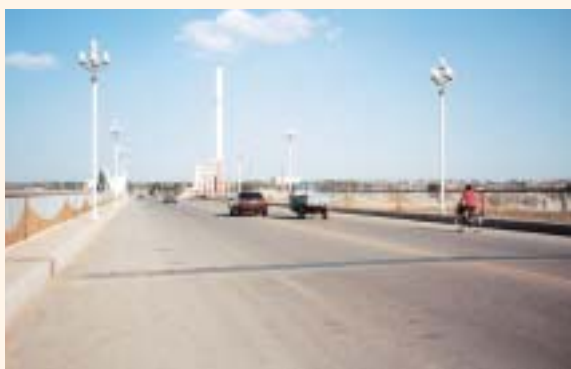
本事業により建設された道路橋（東江橋）
