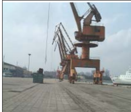
サイト写真：第1・2バースに設置された荷役機械
