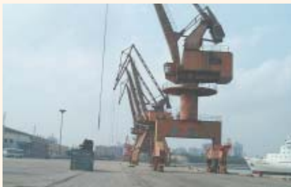
第1・2バースに設置された荷役機械
