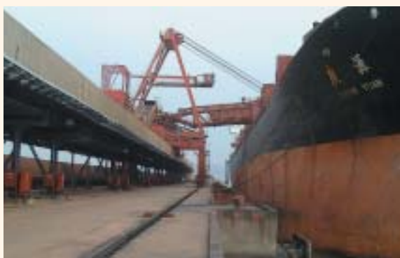
本事業により建設された石炭パース
