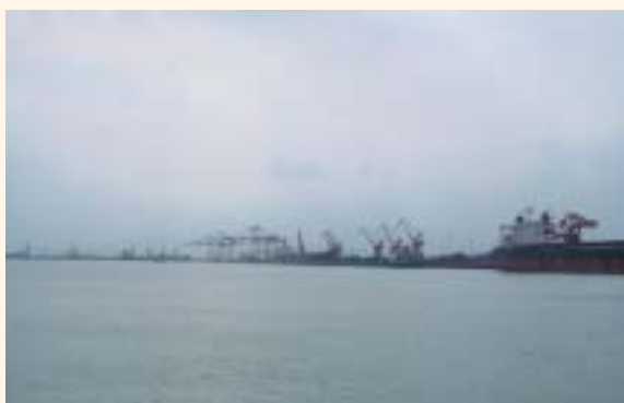
本事業により建設されたコンテナバース
