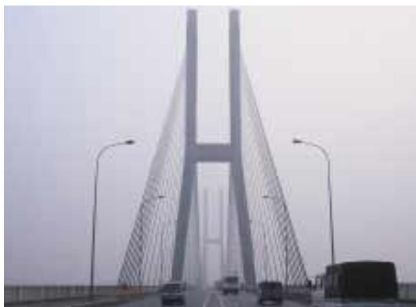
重慶長江第二大橋建設事業
