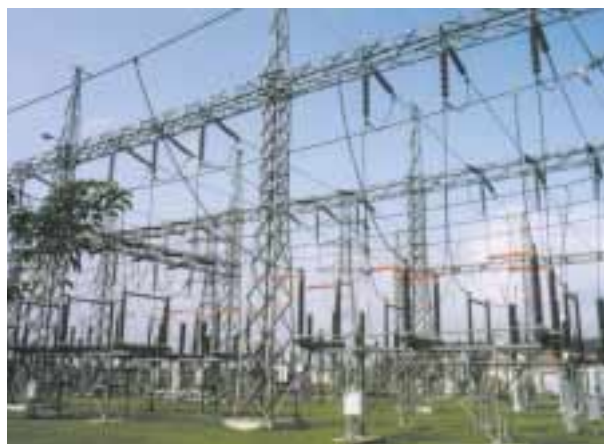
インドネシア「東部ジャワ送配電網建設事業（4）」
