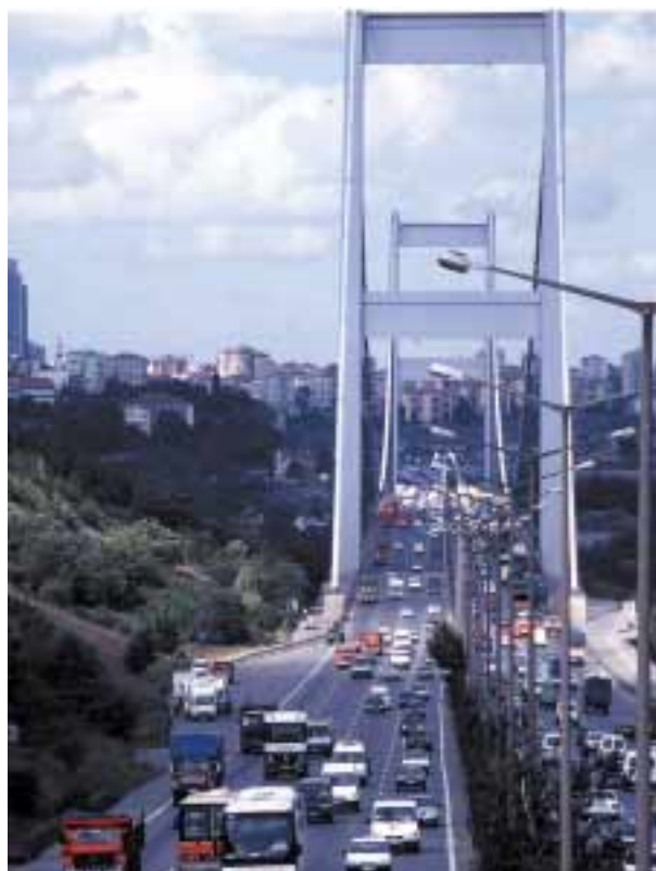
トルコ「第2ボスボラス橋・高速道路建設事業」
