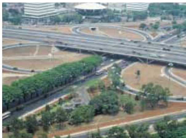
インドネシア「ジャカルタ市内有料高速道路建設事業」
