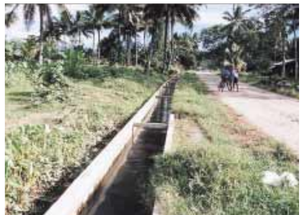
本事業により整備された支線用水路と市場アクセス道路
