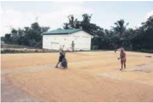
本事業による倉庫と天日乾燥施設
