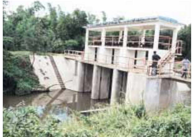
本事業による取水堰
