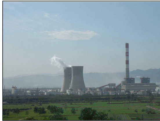
河津発電所全景
