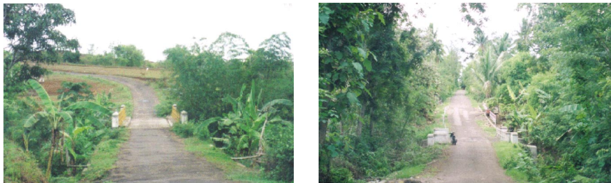
図2 本事業で架け替えられた橋梁 (南スラウェシ州ボネ県にて)
