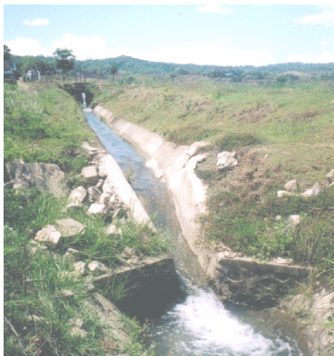
図6 水利組合により修繕された2次水路の落水工
