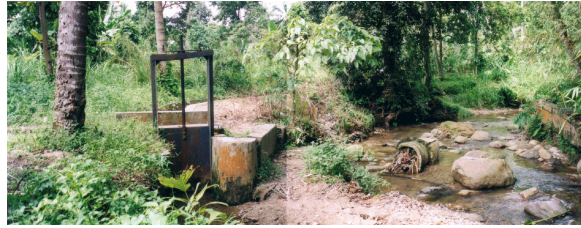
図-6 本事業により修復された村落灌漑スキームの例
