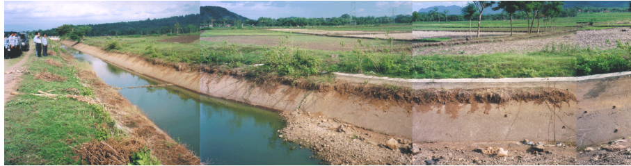
図-2 本事業によりライニングが修復された1次水路区間
