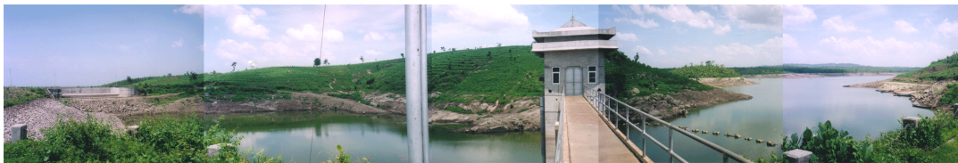
図-4 本事業により建設されたサンギラン・ダム
