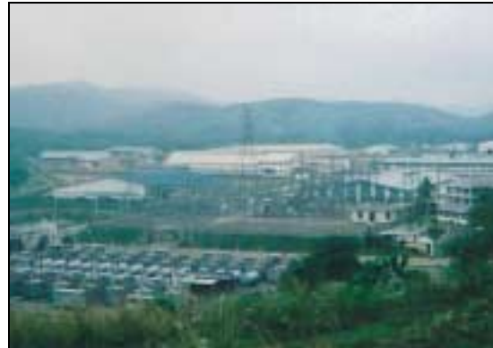
シータワカ工業団地全景
