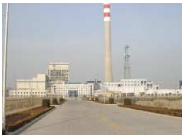
中国 三河火力発電所建設事業(1)(2)
