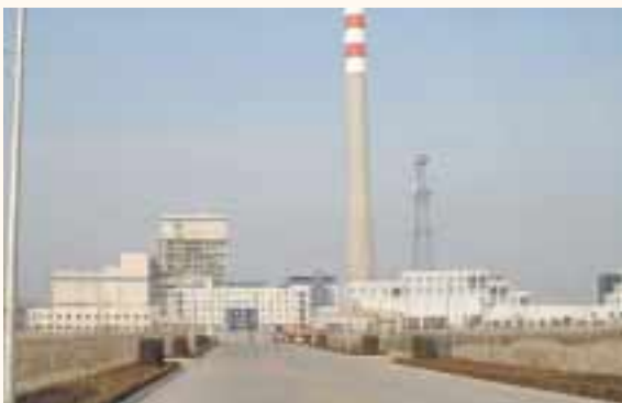
本事業により建設された三河火力発電所
