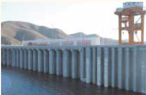
本事業により建設された白石ダム
