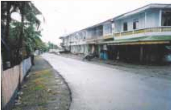
本事業により整備された地方道路(ゴネ県)
