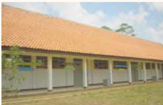
本事業により新設された中学校校舎
