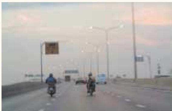
本事業により建設された新クルンテープ橋
