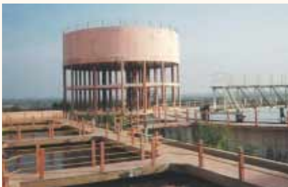
本事業により建設された浄水施設（ソラプール）
