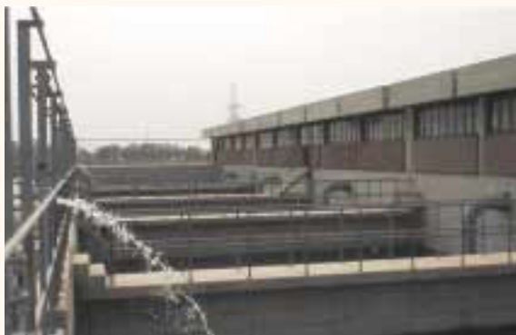
本事業により建設されたカンプール浄水場
