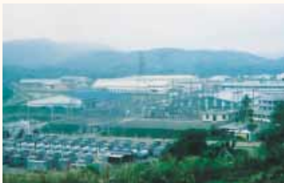
本事業により建設されたシータワカ工業団地
