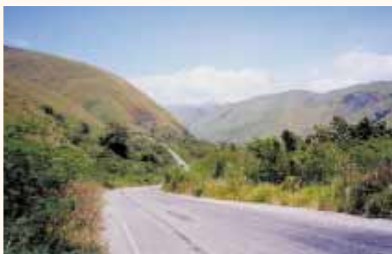
本事業により整備された国道
