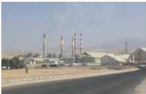
本事業により増設されたアカバ火力発電所
