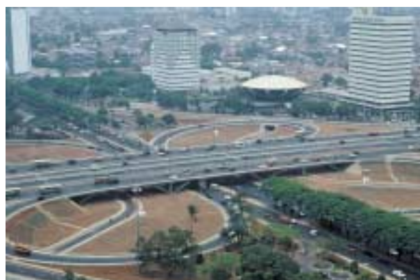
インドネシア ジャカルタ市内有料高速道路建設事業
