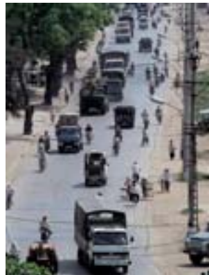
ベトナム北部の国道5号線。上海スケーリングアップ会合で発表された「ベトナム北部交通インフラ事業インパクト評価」の対象事業の一つ。
