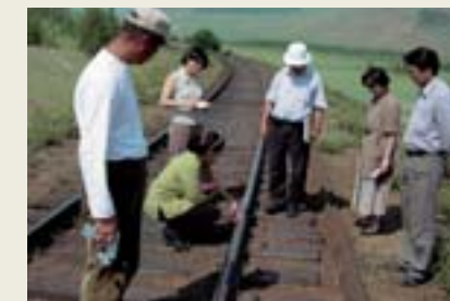
本事業では耐久性に優れた頭面焼レールが設置された。
