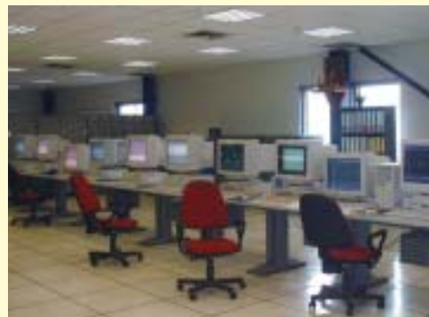
排煙脱硫装置コントロール室に国内外からのさまざまな視察団を受け入れ、技術の普及を図っている。
