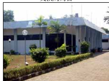
図2 本事業により建設された 交換局局舎
