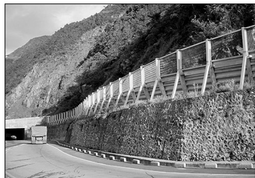
写真-3 ツバ地区の落石防護フェンス
