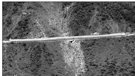
写真-1 プゴ-バギオ間に建設されたロックシェッド 写真-2 ロックシェッド施工区間の遠景
