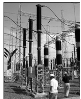
写真-3 設置された遮断器
