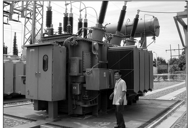
サン・エステバン変電所に設置された 50MVA 変圧器
