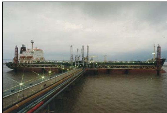
本事業により建設された第二石油栈橋
