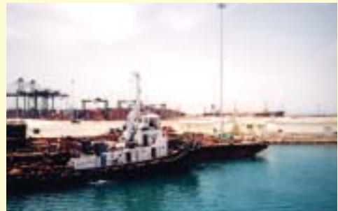
浚渫されたツチコリン港港内泊地
