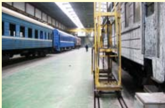
本事業で新設されたアルマティ客車修理工場の内部
