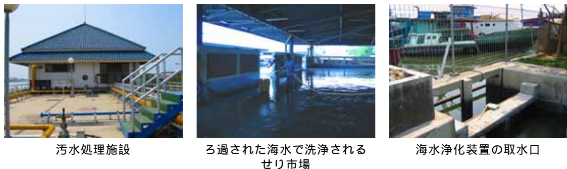
図 5: 漁港内の衛生水準向上のための施設
