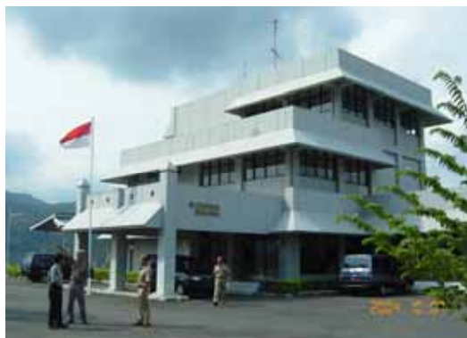
ダム施設の管理棟
