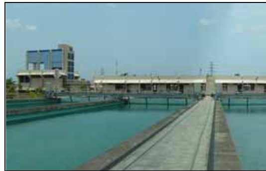
浄水施設（沈澱槽）
