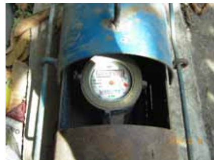
図3：本事業で交換された水道メーター
