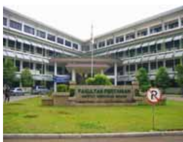
本事業により建設された農学部校舎
