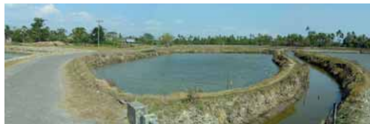
エビ養殖池：水路と道路のリハビリが実施された
