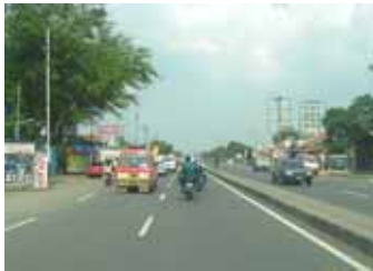
バンドン市内の道路拡幅区間
