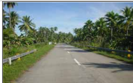
本事業にて改良された幹線道路
