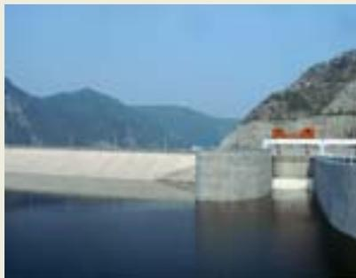
黒河ダムの総貯水量は2億429万 $m^3$ と、富山県の黒部ダム(約1億9,928万 $m^3$ )と同規模である。本事業により建設された発電所(最大出力20MW)の発電量は、04年6月から05年5月の実績で65,600MWh/年とほぼ計画値65,930MWh/年に達している。
