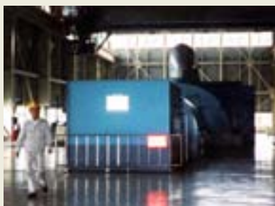
発電所のボイラー
