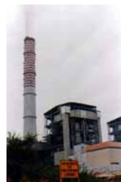
図 3 アンパラ B 火力発電所全景
