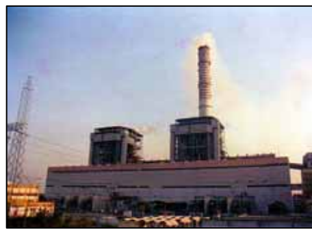
アンバラ B 火力発電所全景
