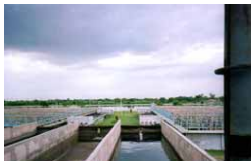
本事業により整備された下水処理場
