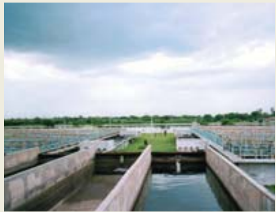
外部評価者 中村 千亜紀(グローバル・リンク・マネージメント(株)) 現地調査 2004年9月
